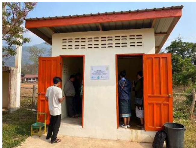
Abri dans lequel est installée une fontaine rendant l'eau potable
