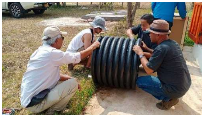
Montage de la fontaine
