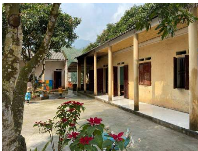
Ecole maternelle du village de Hon construite en 2003
