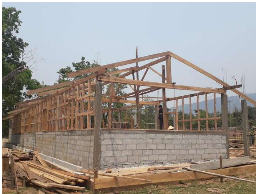
Travaux en cours
