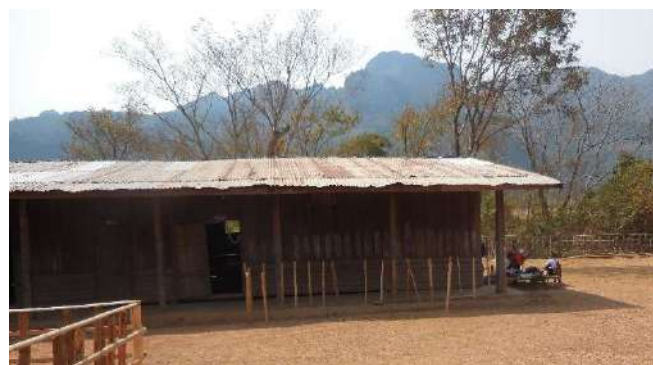
L'école de Nong Seng avant les travaux : 2 salles de classe
