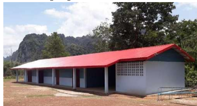
Après les travaux : 4 salles de classe, un préau, une cuisine et des rampes d'eau
